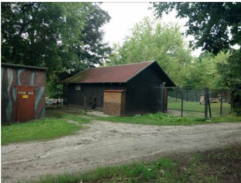
Fot. nr 3. Widok istniejącego domku dla Takinów od strony obsługi technicznej oraz stacji trafo.
