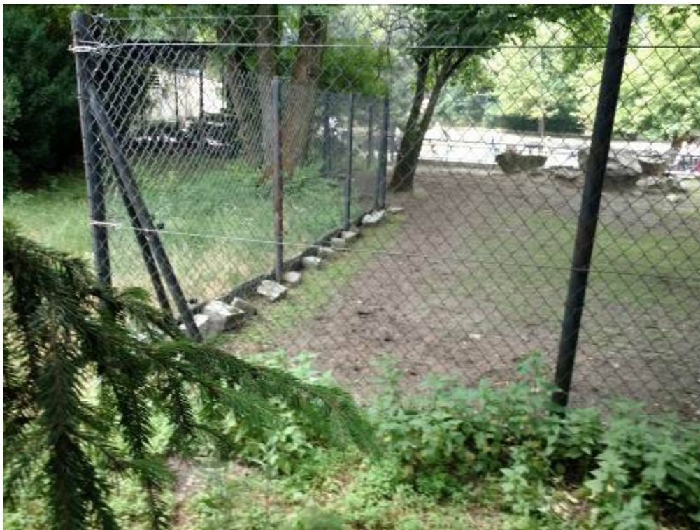
Fot. nr 8. Widok ogrodzenia z siatki (miejsce projektowanej bramy przesuwnej).
